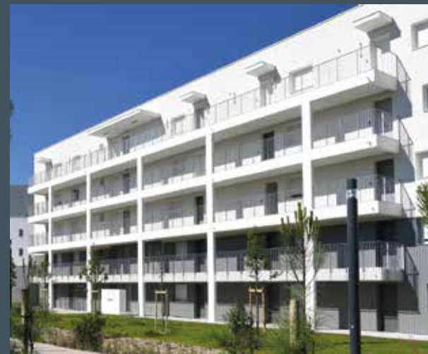
Dean - Projet Ardillos - Mérignac (33) - 63 logements livrés en juin - Architecte : Teissere et Touton
