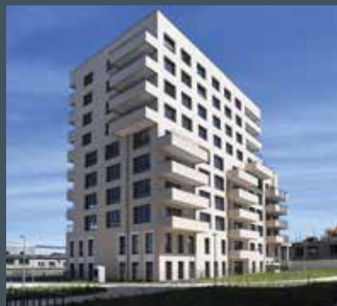
Green Station - Bordeaux (33) - 40 logements livrés en mai - Architecte : ELEX Éric Lapiere Expérience
