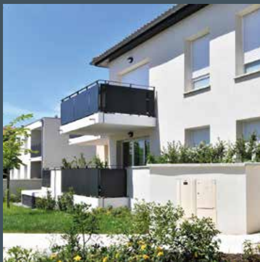
L'émail noir - Saint-Alban (31) - 23 logements livrés en décembre - Architecte : AM PM Architectes
