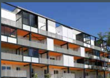
Sherwood - Projet Ardillos - Mérignac (33) - 39 logements - livrés en juin - Architecte : Andrieux Lacavetne et Daquin Ferrière
