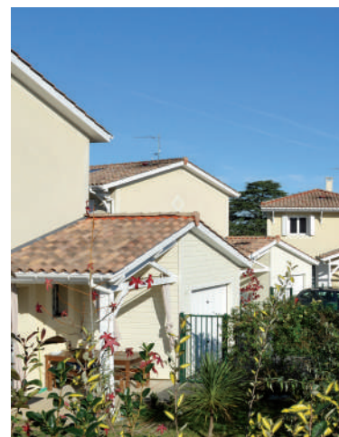
Naujan et Postiac (33) architecte : Grégory Martin
