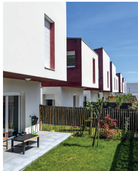
Bruges (33) - architectes : A. Triaud & Arsène-Henry
