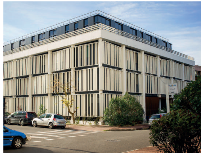
Siège de Mésolia - Bordeaux (33) architecte: Cabinet Luc Arsène-Henry & Alain Triaud
