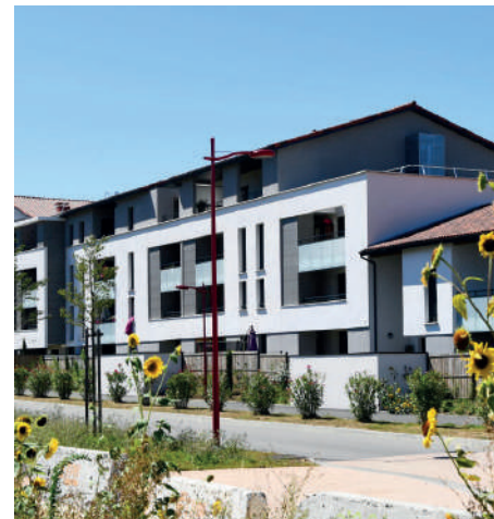
Péchabou (31) architecte : ABC Architecture
