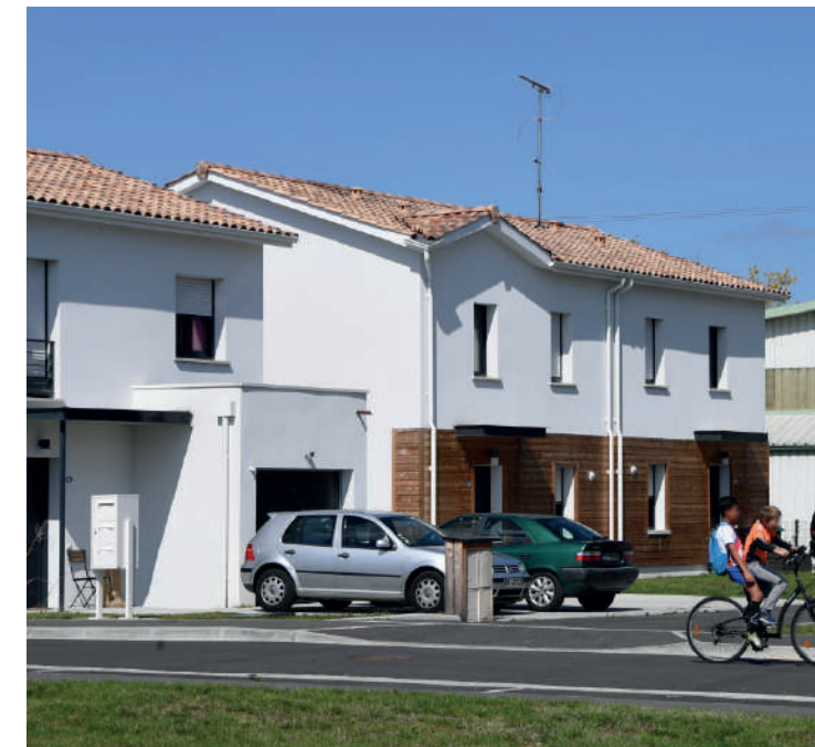
Ambarès (33) - architecte : Artotec
